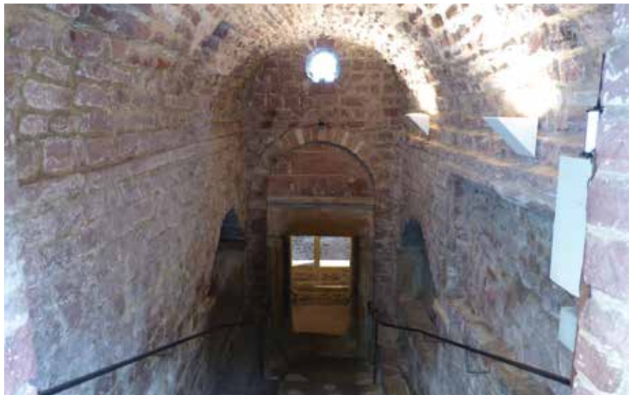
תמונה 4: המקווה בשפייר, מסדרון הכניסה. מבט לכיוון החלונות המפרידים בין חדר ההכנה לבין הפיר ובריכת הטבילה. צילום: נטע בודנר
